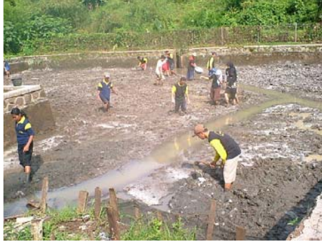
Gambar 2.37. Pengolahan tanah dasar kolam
